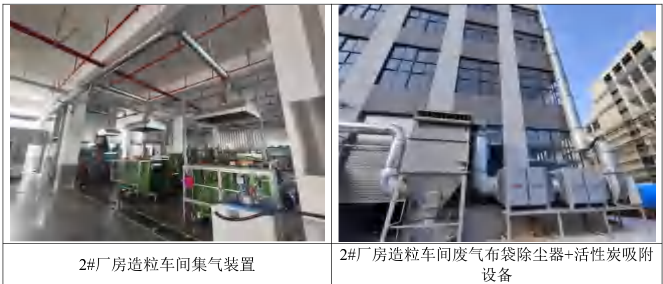
图 4-5 2#厂房 1F 造粒车间废气处理设施图
